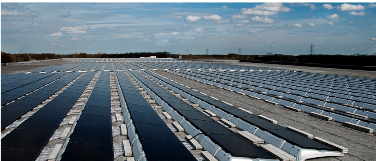
Zonnepark Ecofactorij is gereed en levert stroom.
